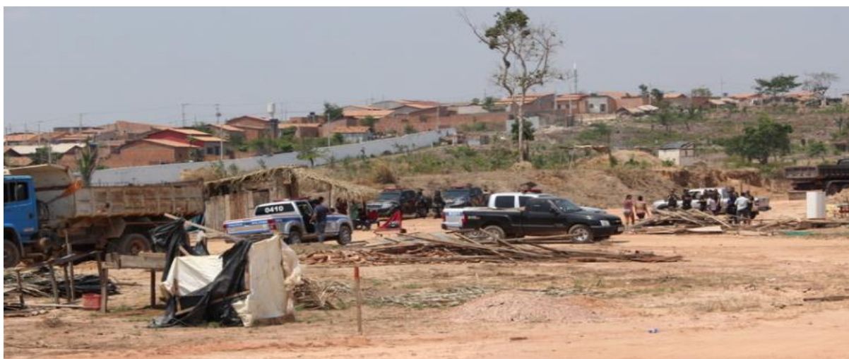
Figura 5 – Muro que faz divisória entre o Bairro Newton Miranda e a Invasão da Infraero.
